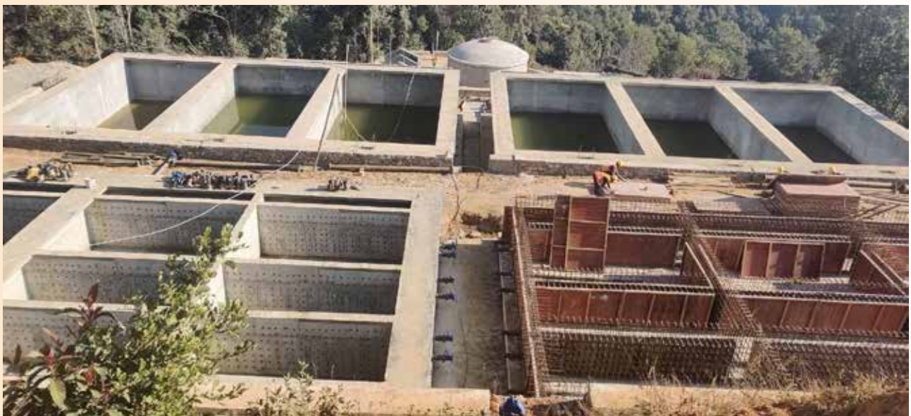
(फोटो नं. ४ : सिलुचुङ्ग खानेपानी तथा सरसफाई आयोजनाको निर्माणाधिन संरचना )
