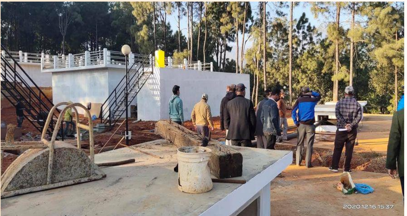
(फोटो नं. २ : निर्माणाधिन विदुर साना शहरी खानेपानी आयोजना)
