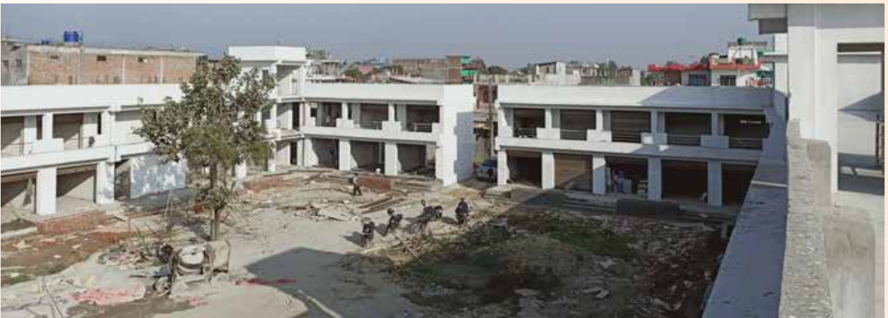
(फोटो नं. ७ : हरिवन नगरपालिका स्थित बजार क्षेत्र विकास आयोजनाको निर्माणाधिन संरचना )
