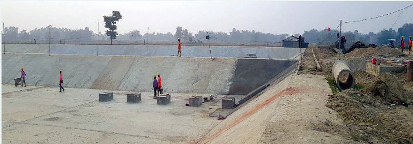
फोटो नं. १० : विरगंज उप-महानगरपालिकामा निर्माणाधीन फोहोर पानी प्रशोधन पोखरी
