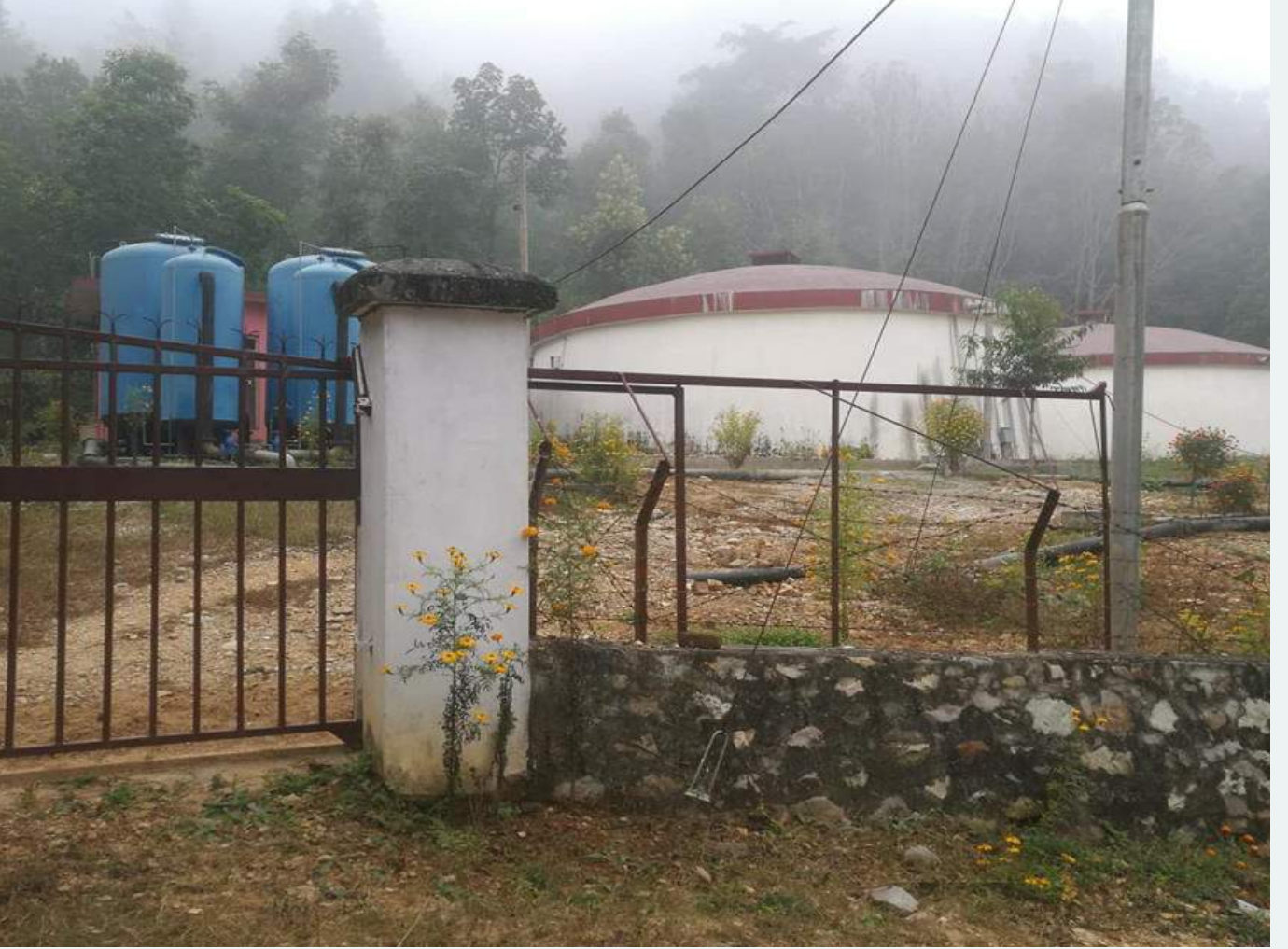
फोटो नं. ७ : नगर विकास कोषको ऋण सहयोगमा निर्मित रामपुर साना शहरी खानेपानी तथा सरसफाई आयोजनाको पानी ट्याकी सहितको पानी प्रशोधन उपकरण (रामपुर, पाल्पा) ।
