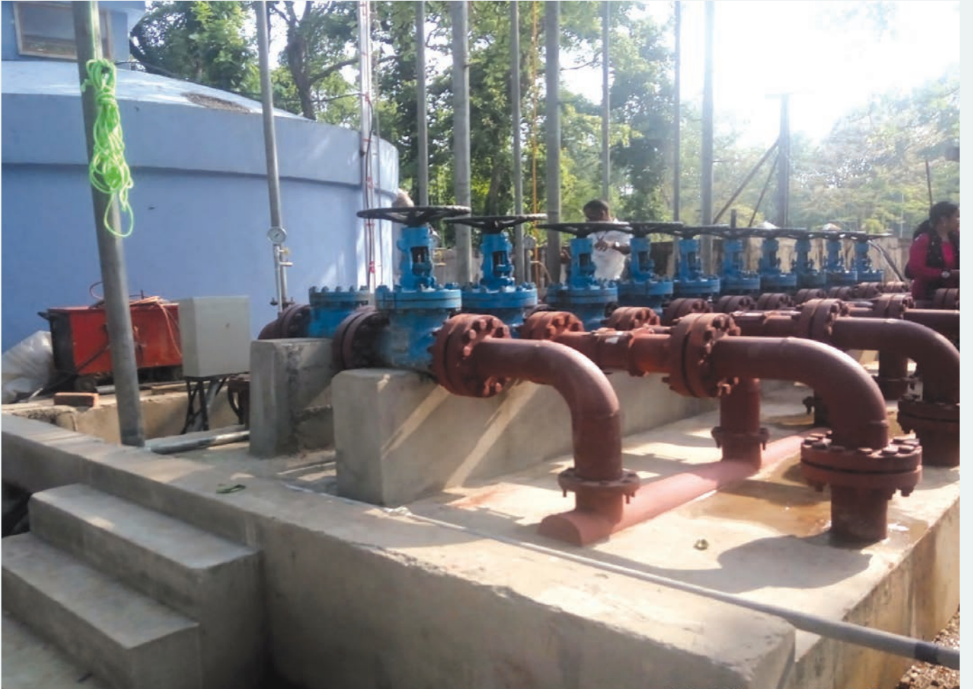
फोटो नं. ११ : धरान उप-महानगरपालिकामा निर्माणाधीन खानेपानी आयोजनाको खानेपानी प्रशोधन केन्द्र
