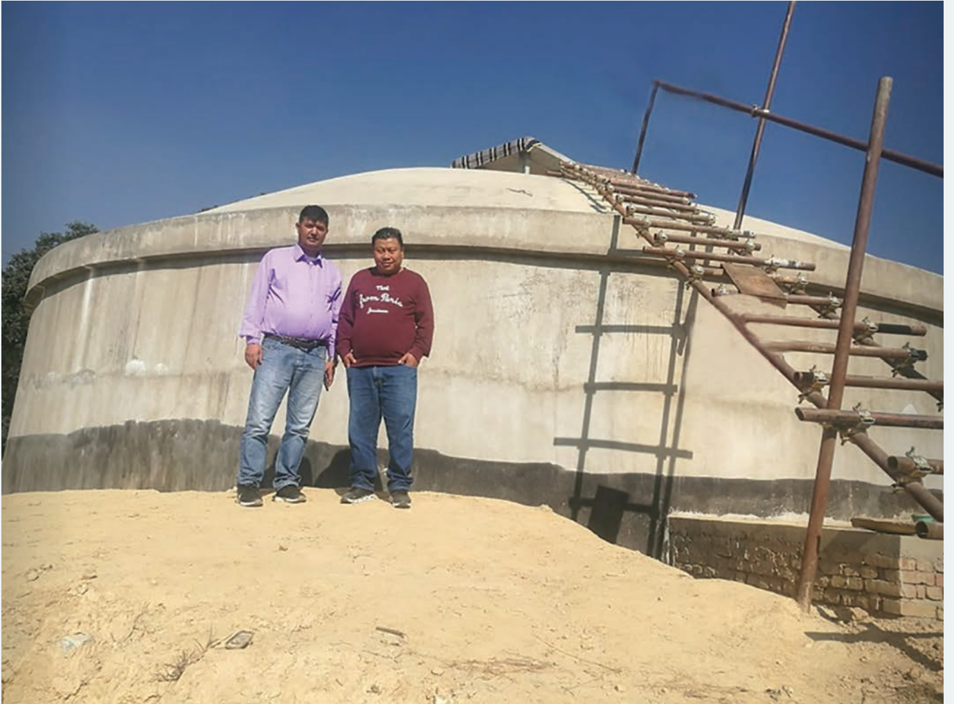
फोटो नं. ९ : सह लगानी कार्यक्रम अन्तर्गत निर्माणाधीन विन्दवासीनी खानेपानी आयोजनाको ट्याङ्की
