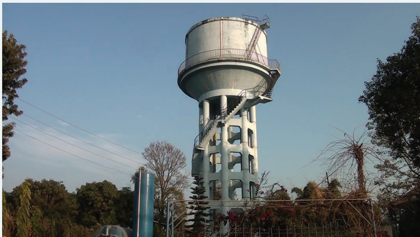
फोटो नं. ६: साना शहरी खानेपानी तथा सरसफाई आयोजना प्रथम चरण अन्तर्गत निर्माण भएको तुलसीपुरको ओभरहेड पानी ट्याङ्की
