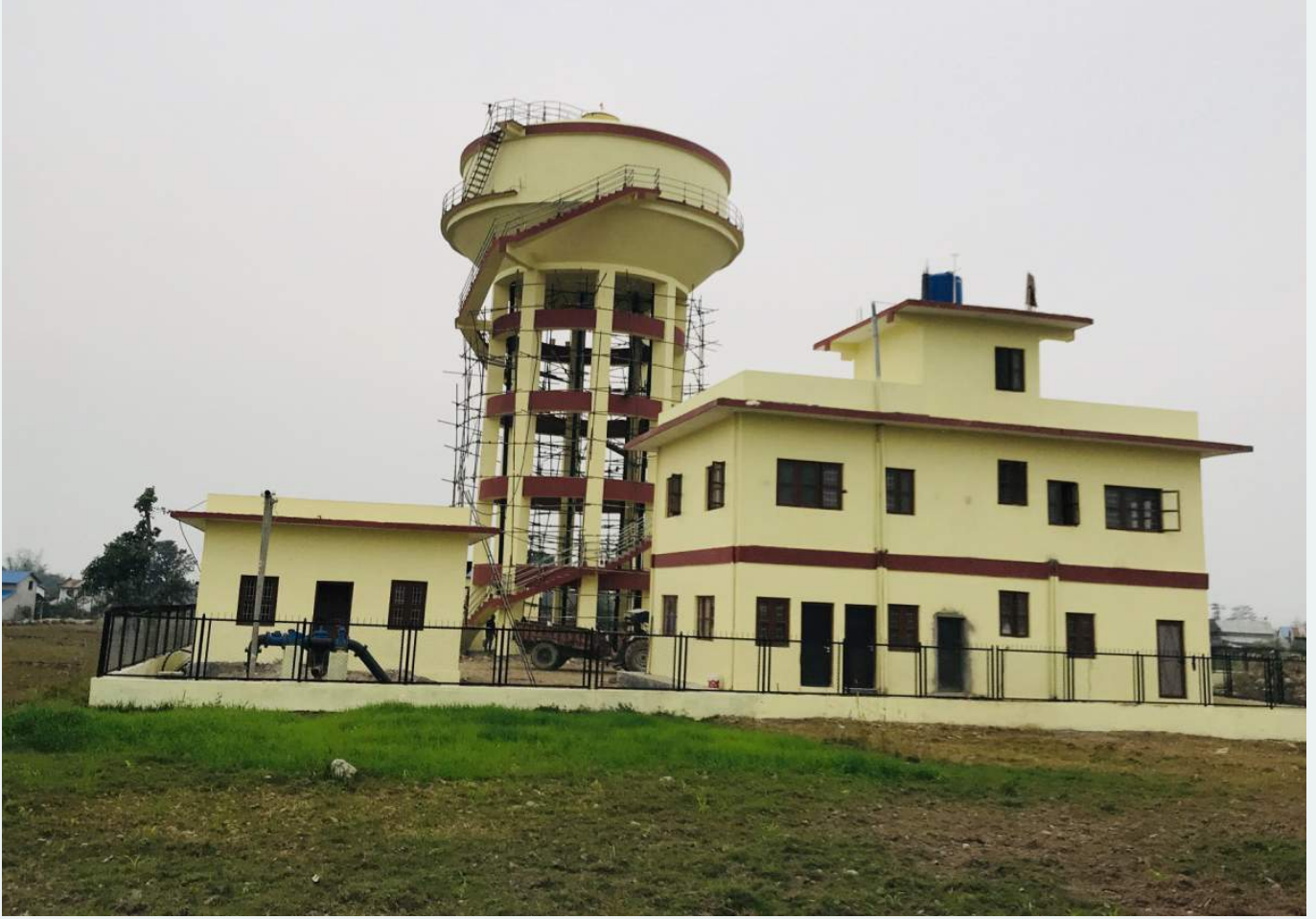
फोटो नं. ८ : नगर विकास कोषको ऋण सहयोगमा साना शहरी खानेपानी तथा सरसफाई आयोजना तेस्रो चरण अन्तर्गत विरेन्द्रनगर चितवनमा निर्मित विरेन्द्र साना शहरी खानेपानी तथा सरसफाई आयोजनाको मुख्य संरचनाहरू
