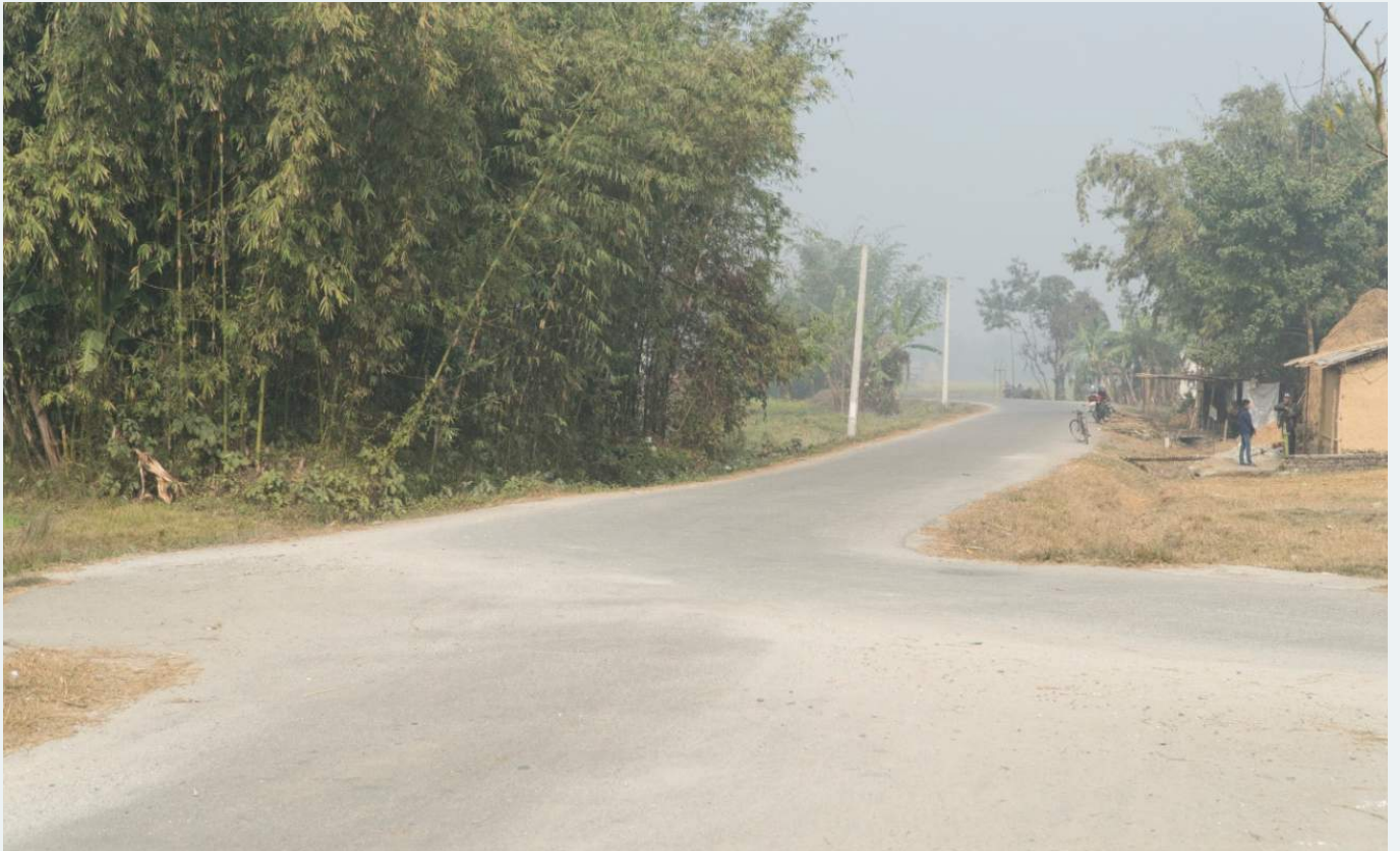
फोटो नं. ५ : नगर विकास कोषको चक्रीय कोष अन्तर्गत ऋण तथा अनुदान सहयोगमा निर्मित कोशी हरैचा नगरपालिका स्थित कालो पत्रे सडक खण्ड
