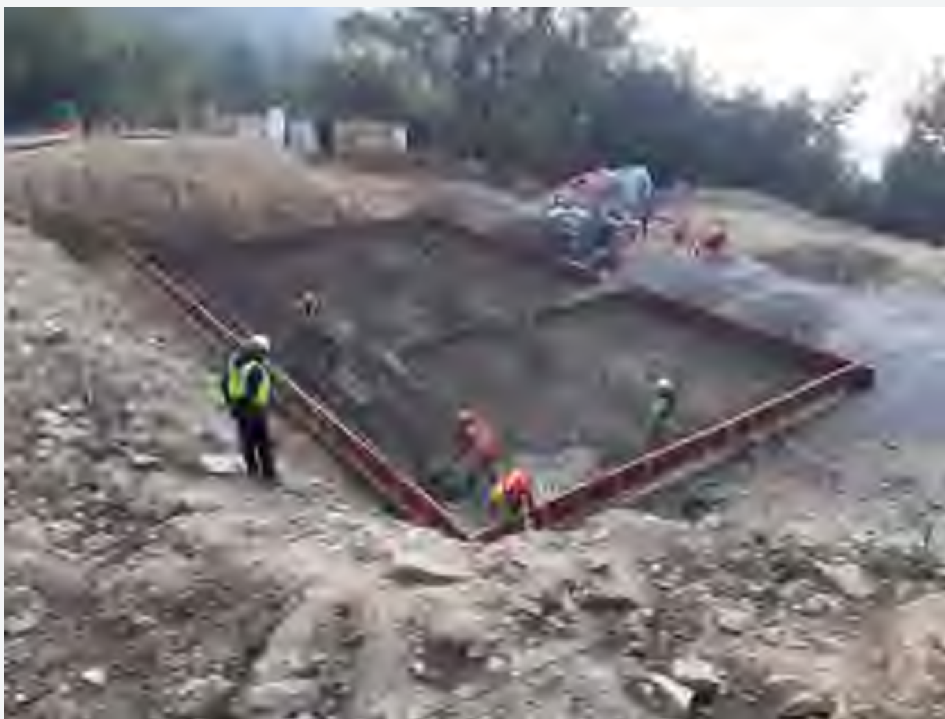
फोटो नं. ६: शहरी खानेपानी तथा सरसफाई आयोजना अन्तर्गत निर्माणाधिन चरिकोट खानेपानी तथा सरसफाई आयोजनाको पानी प्रशोधन केन्द्र
