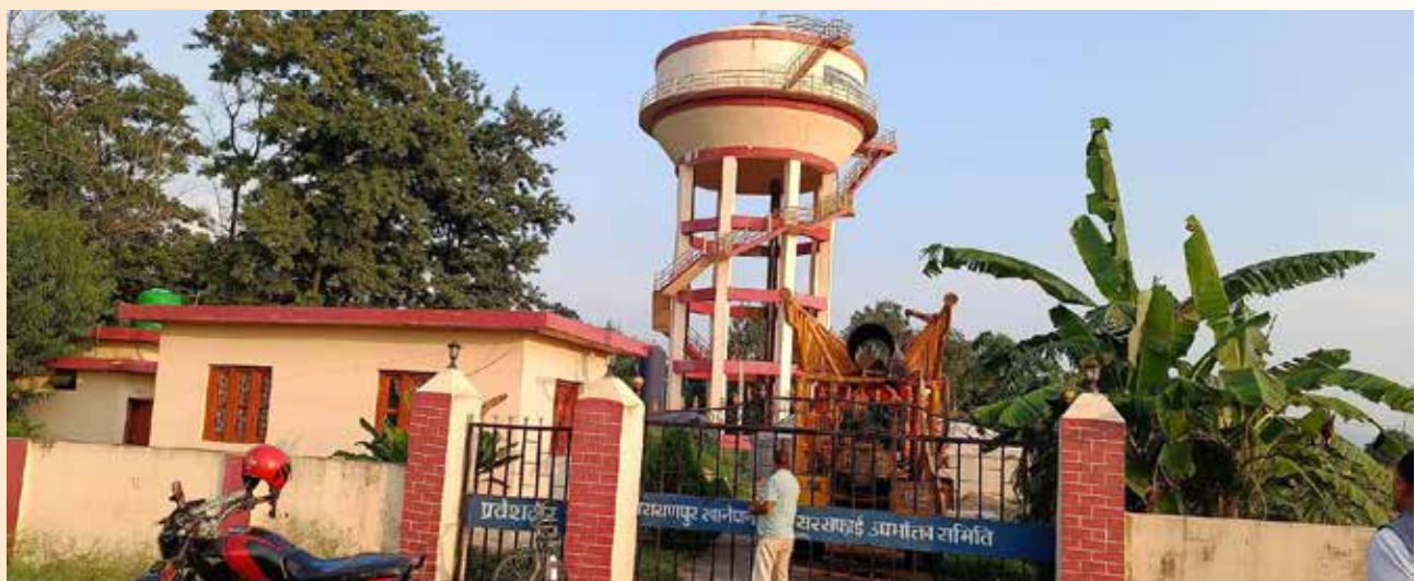
(सहलगानी खानेपानी आयोजना अन्तर्गत सम्पन्न नारायणपुर खानेपानी आयोजनाको संरचना)
