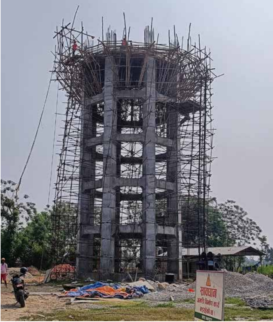
(शहरी खानेपानी आयोजना अन्तर्गत शारदानगर खानेपानी आयोजनाको निर्माणाधिन संरचना)
