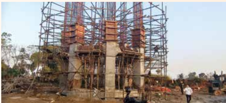
(फोटो नं. ७ : शहरी खानेपानी तथा सरसफाई आयोजना अन्तर्गत शारदानगर खानेपानी आयोजनाको निर्माणाधिन भौतिक संरचना)
