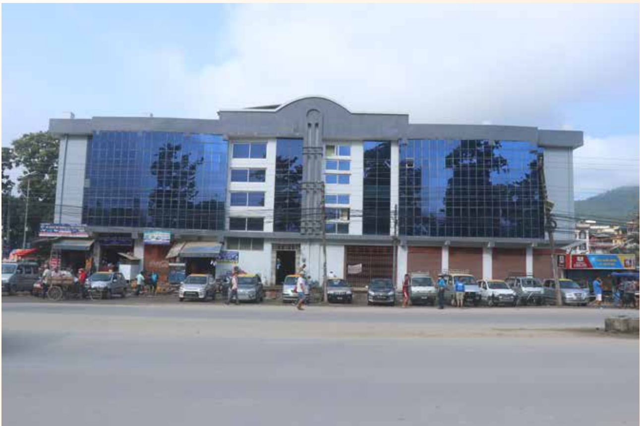
(फोटो नं. ४ : शहरी पूर्वाधार विकास आयोजना अन्तर्गत वुटवलमा निर्माण सम्पन्नको चरणमा रहेको व्यापारिक भवन)
