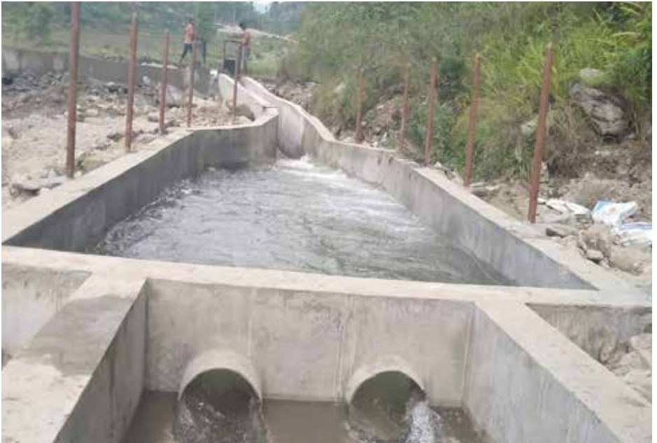
बिदुर साना शहरी खानेपानी तथा सरसफाइ आयोजना अन्तर्गत निर्मित खानेपानी आयोजनाको इनटेक संरचना
